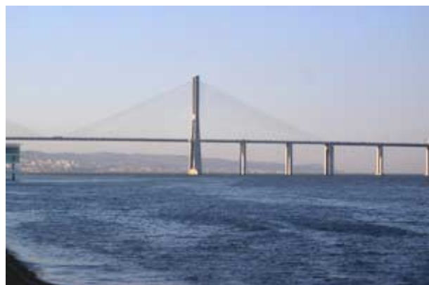
Ponte Vasco da Gama
